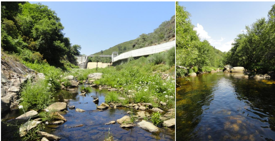
Fotos 15: Local de amostragem situado a jusante do AH de Vales, no rio Tinhela (Va2j)
