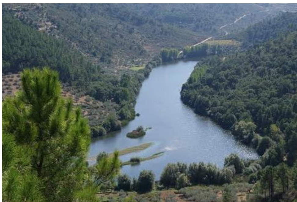
Figura 7. Albufeira do Aproveitamento Hidroelétrico de Torga.
