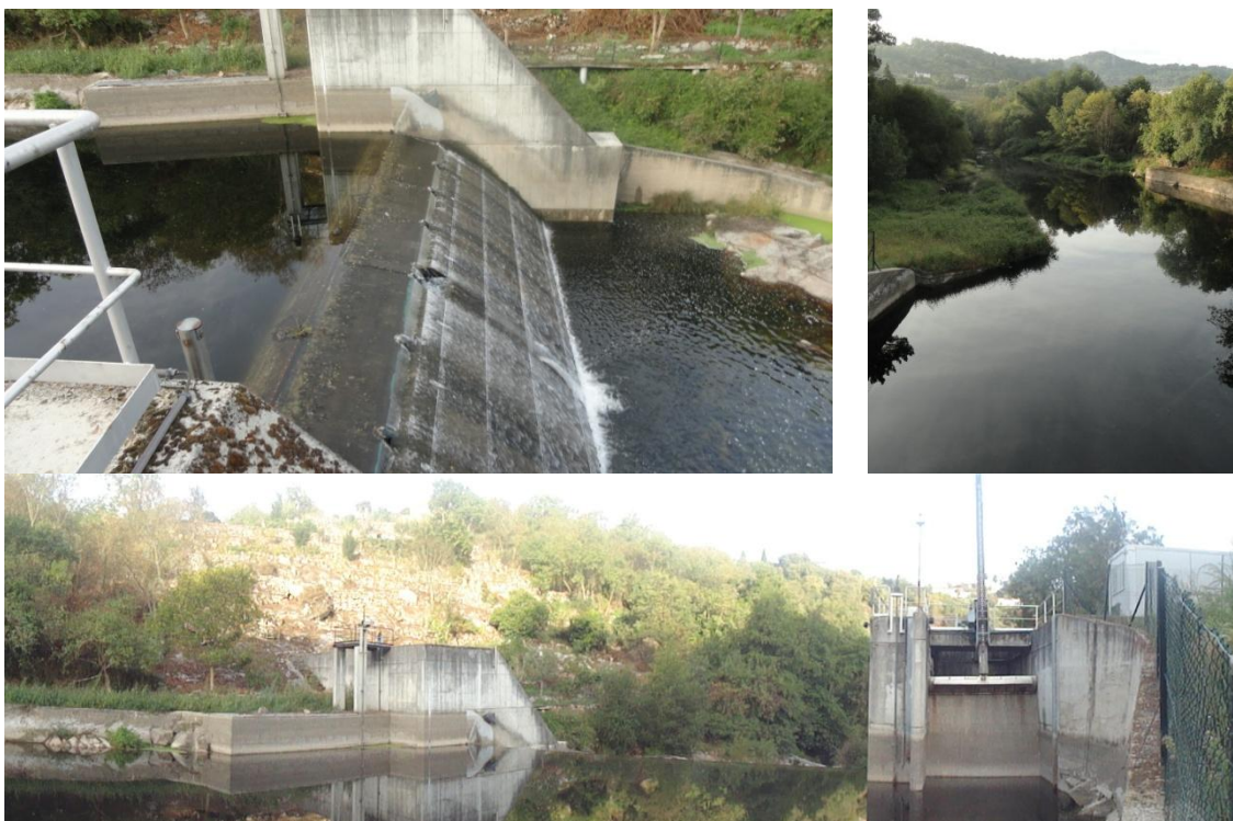
Figura 9. Aproveitamento Hidroelétrico de Ucanha Gouviães
