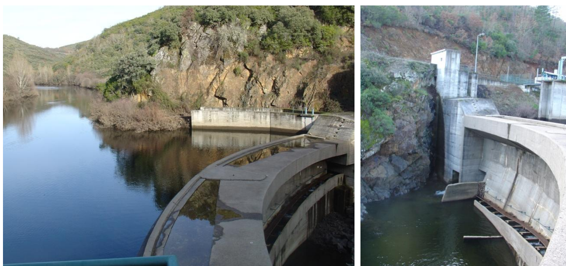
Figura 3. Aproveitamento Hidroelétrico de Nunes
