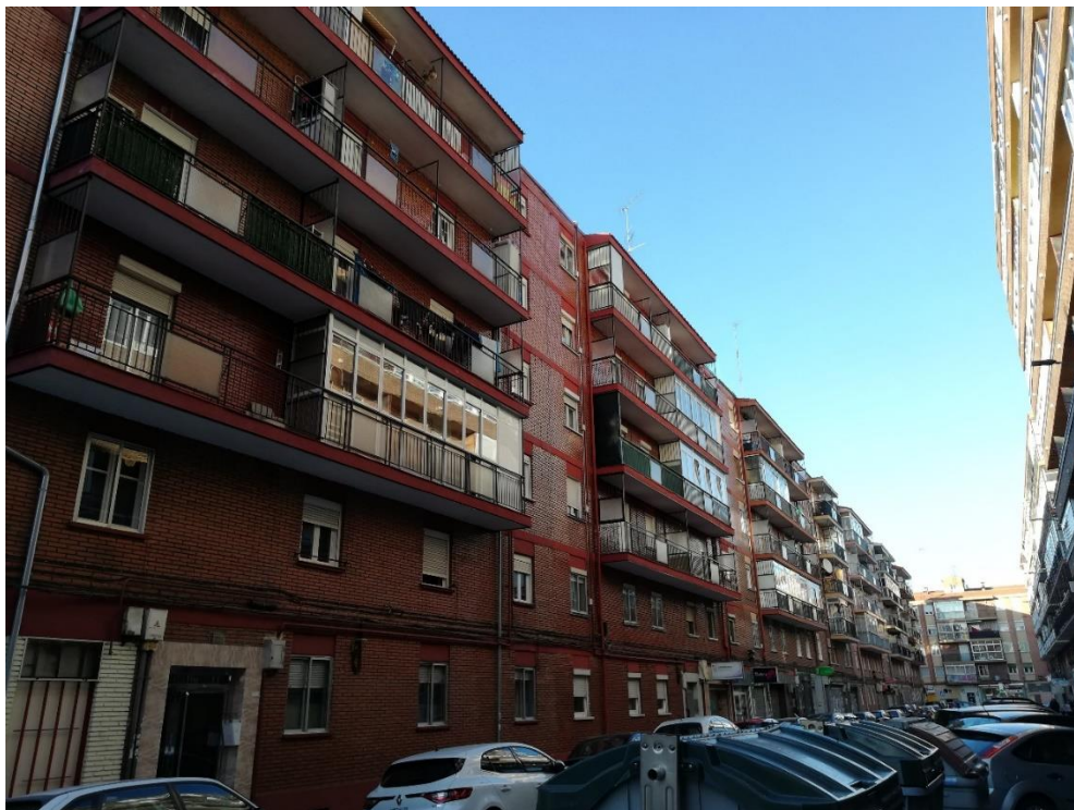
Ilustración 1: Conjunto de viviendas en calle Gallo, Valladolid
