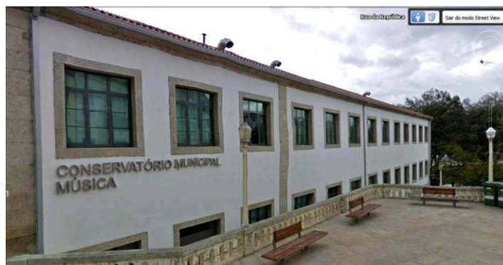
Imagem 5 – Instalações do Conservatório de Música de Bragança
