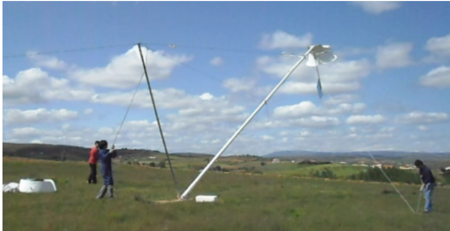
Figura 3.14: Elevação do protótipo com o leme
