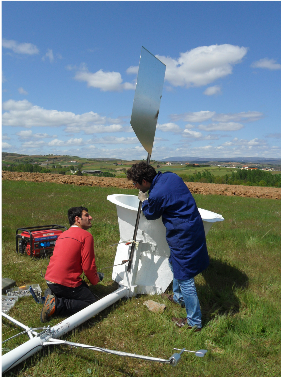
Figura 3.13: Colocação do leme
