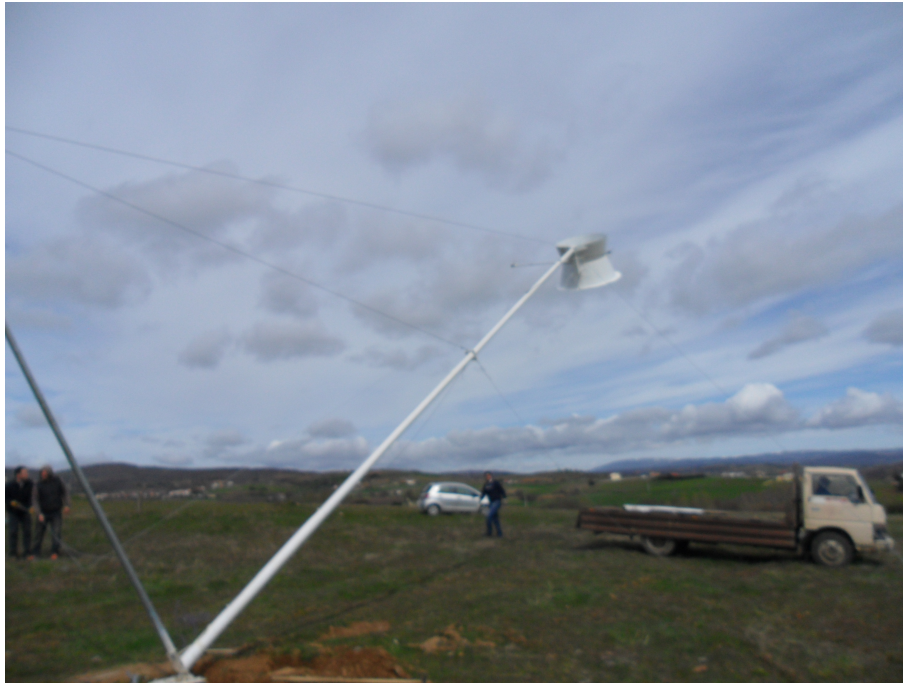
Figura 3.10: Elevação da torre com o protótipo 2
