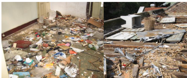
Figura 4.10 - Interior e cobertura de um edifício no decorrer da sua demolição.
