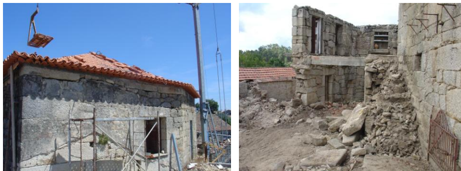
Figura 1.1. e 1.2 – Exemplos de obras a decorrer.
