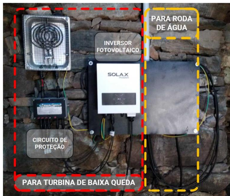
Figura 24: Painel de equipamentos para a injeção de potência do sistema hídrico na microrrede da Casa da Seda, atualmente.
