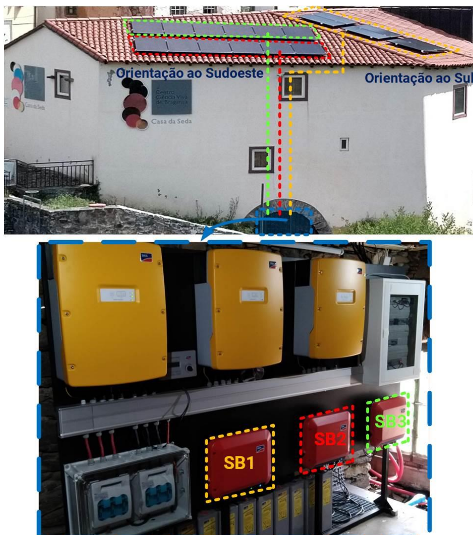
Figura 19: Sistema fotovoltaico da microrrede inteligente da Casa da Seda Fonte: Autoria própria
