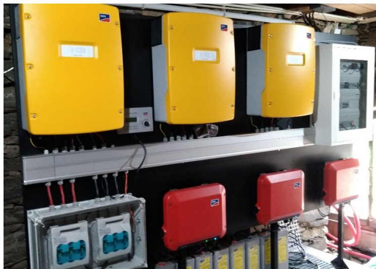
Figura 14: Microrrede inteligente instalada na Casa da Seda Fonte: Autoria própria
