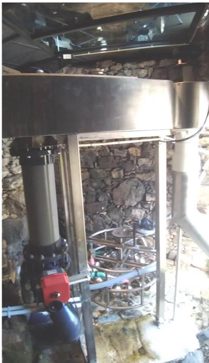
Figura 23: Sistema pico-hídrico da Casa da Seda Fonte: Autoria própria
