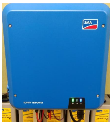
Figura 29: Inversor fotovoltaico Sunny Tripower Fonte: Autoria própria
