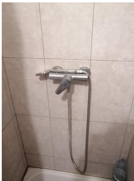
Figura 27 - Duche presente no pavilhão industrial
