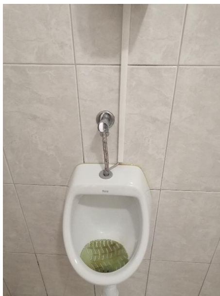
Figura 26 - Urinól presente no pavilhão industrial
