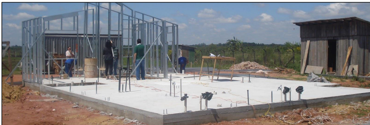
Figura 08. Esperas de ancoragem na laje para fixação da estrutura em LSF
