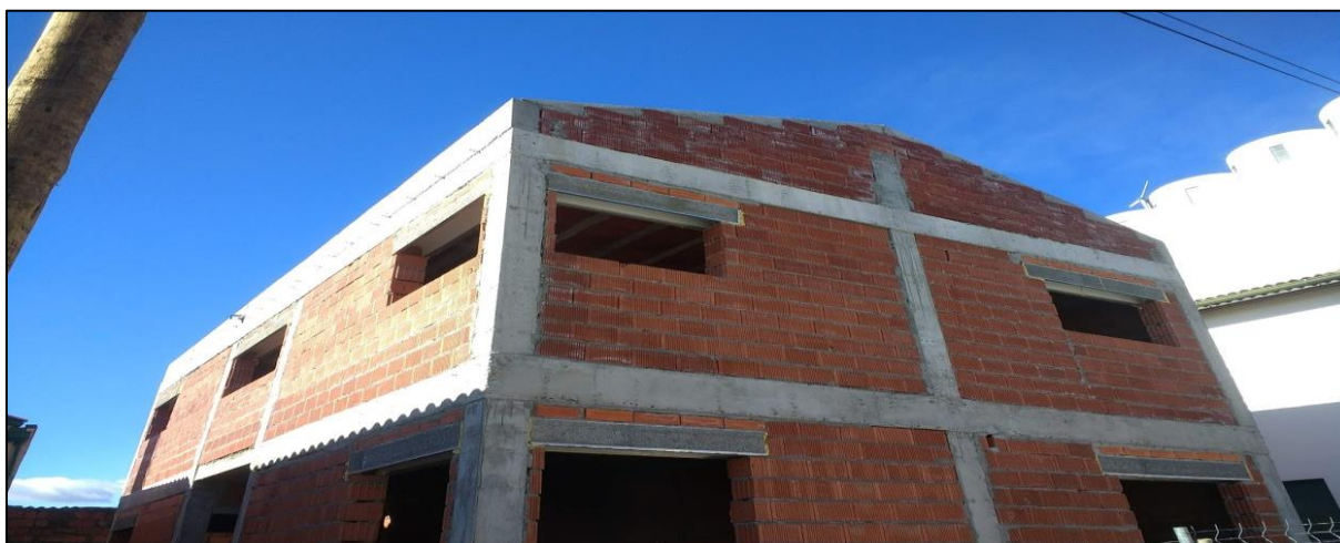
Figura 18. Construção Convencional com Alvenaria de Blocos Cerâmicos, em Bragança Fonte: O autor, 2019
