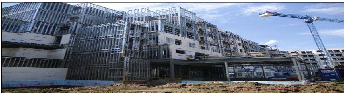
Figura 10. Edificação multi-pavimentos concebida em LSF Fonte: Lightsteelframe.eng.br, 2017
