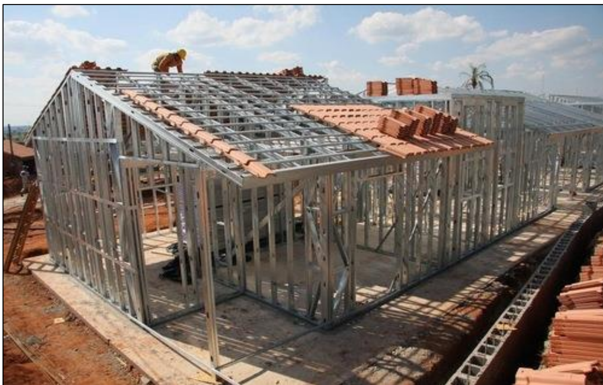
Figura 06. Construção Modular de Habitação em LSF Fonte: FuturEng, 2018
