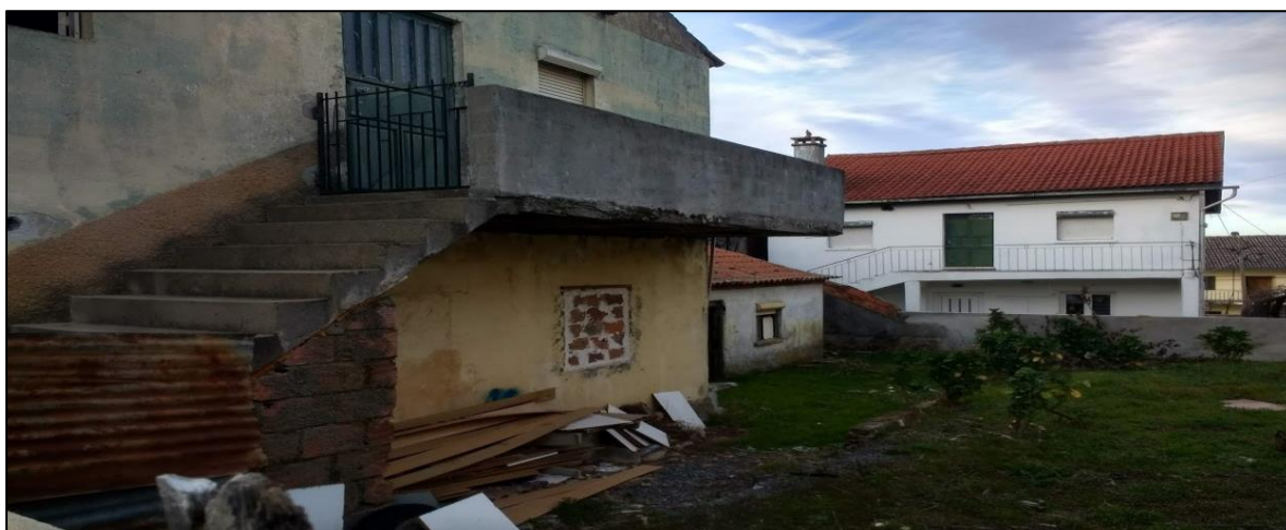
Figura 29. Edificações sujeitas a demolição no terreno Fonte: O autor, 2019
