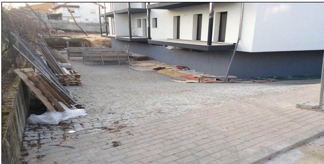
Figura 36. Acesso as garagens e terreno vizinho, da segunda edificação, ainda não iniciada Fonte: O autor, 2019
