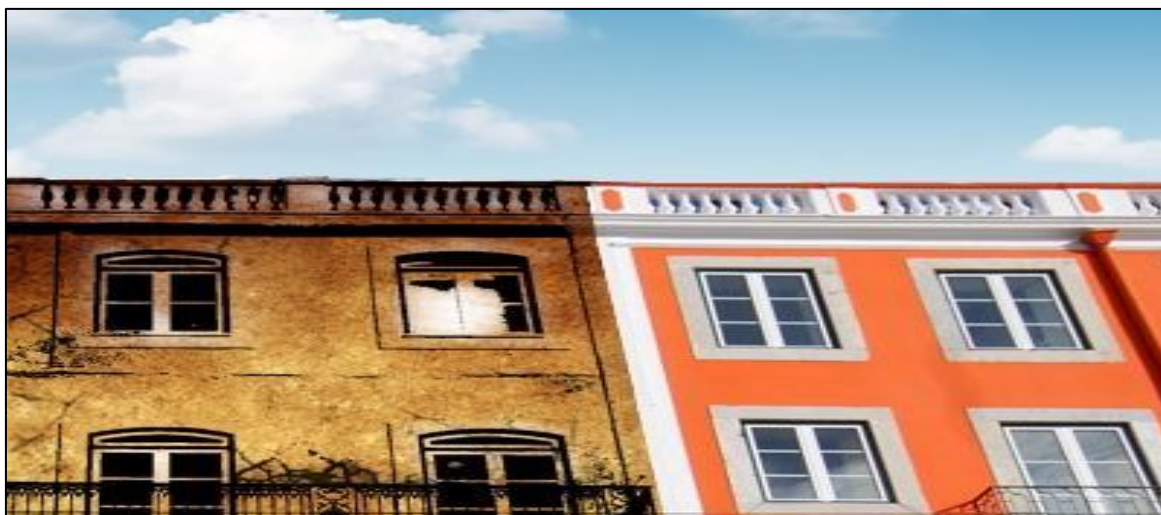
Figura 03. Reabilitação de fachada de edificação Fonte: Casasapo,pt, 2018
