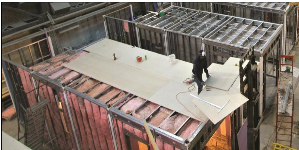
Figura 05. Produção de módulos do tipo volumétrico Fonte: Modular Building Institute , 2018
