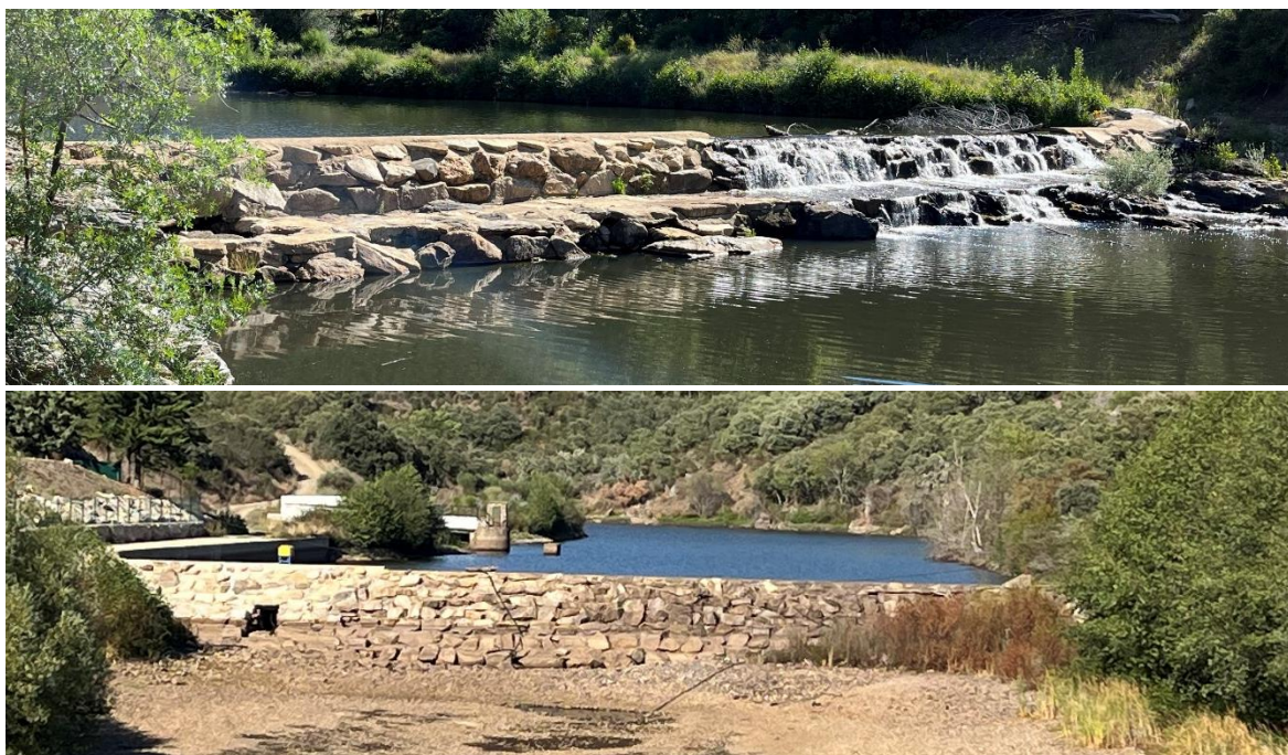
Figura 2.2. Açude situado a jusante da ribeira de Vale de Pena (em cima) e açude de captação de água da ETA de Vimioso (em baixo), ambos localizados no rio Maçãs, na proximidade da aldeia de Outeiro.
