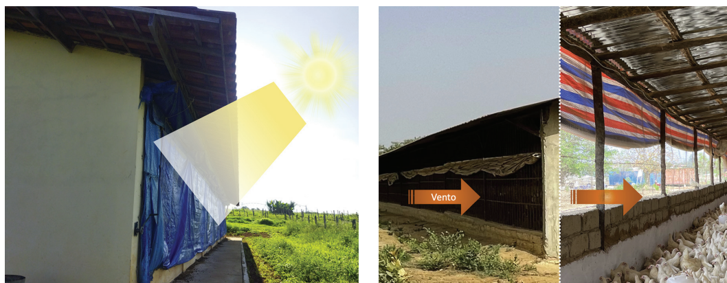
FIGURA 4.15 - As cortinas de um aviário permitem controlar (a) a entrada de luz solar e de chuva e (b) dirigir as correntes de ar.
