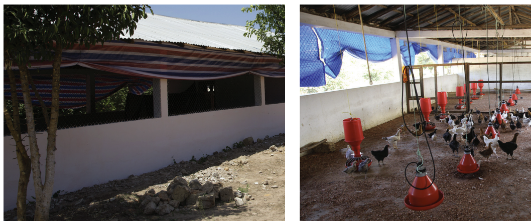
FIGURA 4.13 - Pavilhão para aves com telhados prolongados, alpendre e cortinas.
