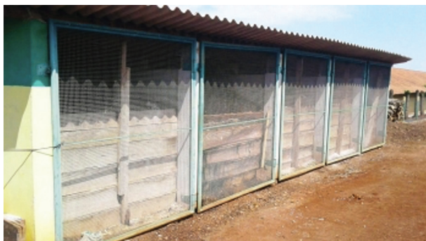
FIGURA 4.60 – Instalações de compostagem.
