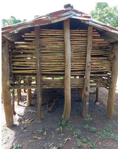
FIGURA 4.9 – Aviário tradicional para galinhas poedeiras construído sobre pilares.
