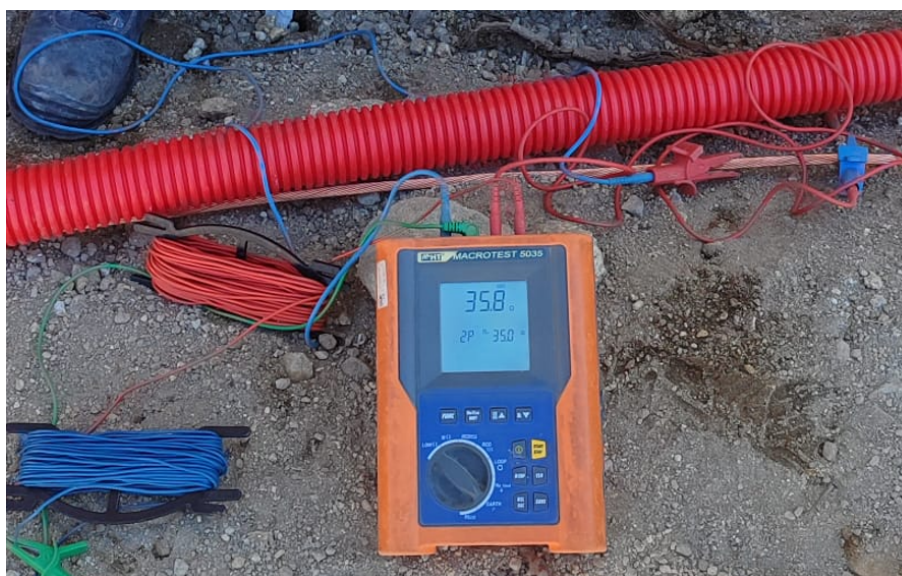
Figura 4.2: Medição da resistência de aterramento [Autoria Própria].
