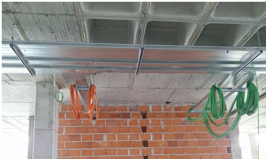
Figura 4.7: Caminho de cabos após a passagem de cabos [Autoria Própria].
