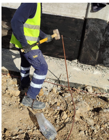
Figura 4.3: Enterramento de elétrodo de terra [Autoria Própria].
