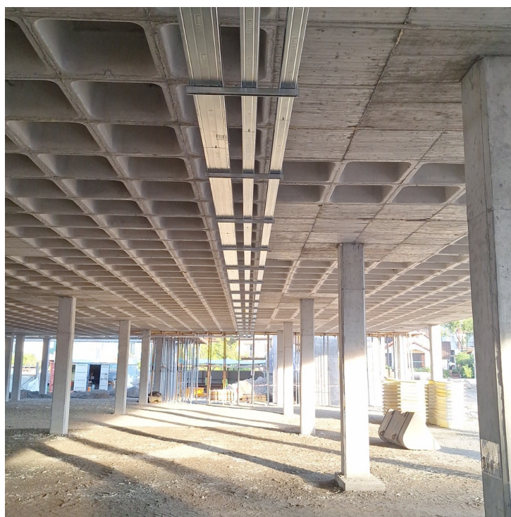
Figura 4.6: Montagem de caminho de cabos [Autoria Própria].
