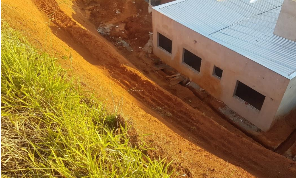
Figura 12 – Conformação do talude após o reperfilamento.
