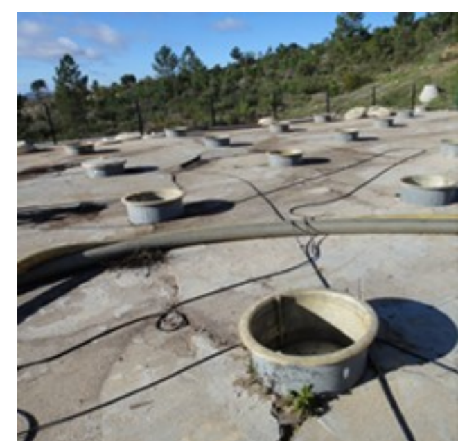
Fig. 2 - Tanques de fermentação
