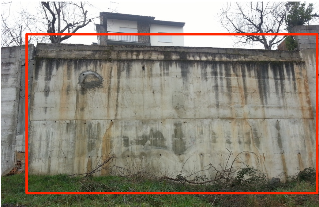
Figura 1 – Muro de suporte de terras.
