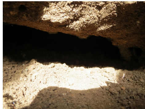
Figura 5 – Galerias na base da ancoragem 3 junto ou muro de suporte.
