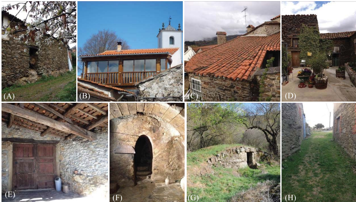
Fig. 1 - Soluções Bioclimáticas (A) Parede de Inércia; (B) Estufa Anexa; (C) Cobertura Captadora, (D) Parede Verde, (E) Espaço de Transição Orientado, (F) Climatização Geotérmica, (G) Cobertura Verde; (H) Arrefecimento Evaporativo.
