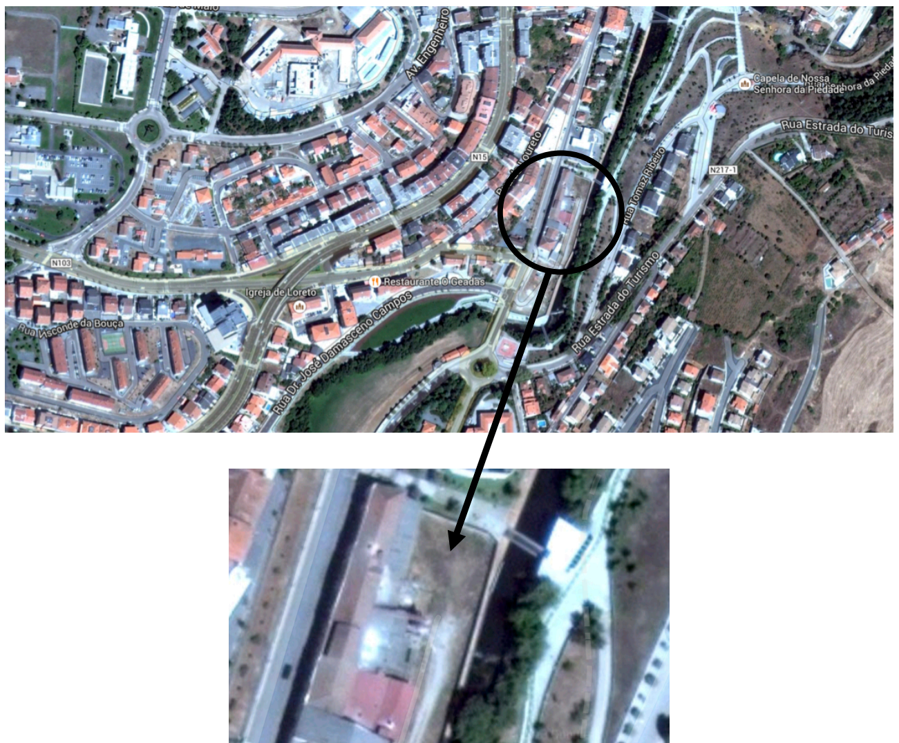
Figura 1 – Vista aérea do local da obra (imagens do Goolge Earth).
