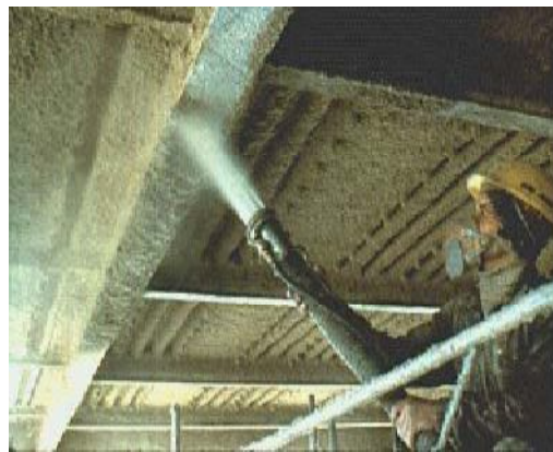
Figura 3.17 Perfil protegido com fibra mineral projectada.
