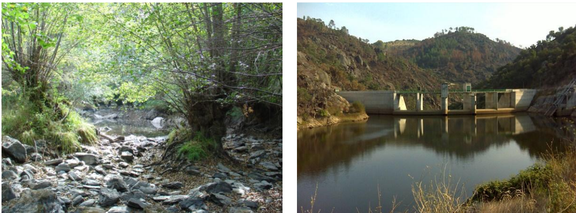
Figura 2.49: Alguns dos fatores de perturbação no meio aquático que afetam a presença e composição das comunidades piscícolas: 1) seca prolongada com depleção de oxigénio nas poças descontínuas (e.g. rio Penacal, verão 2012); 2) regularização de caudais com a construção de obstáculos (barragens) que impedem a circulação de espécies autóctones com migração potamódroma reprodutiva, caso dos barbos e bogas (barragem de Rebordelo, rio Rabaçal).
