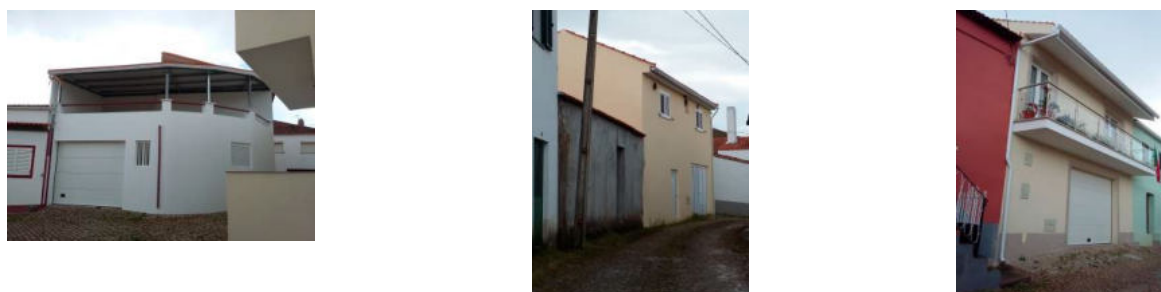
Figura 6: Intervenções em edifícios sem controlo prévio “Registo de Isenção” (sem projeto)
