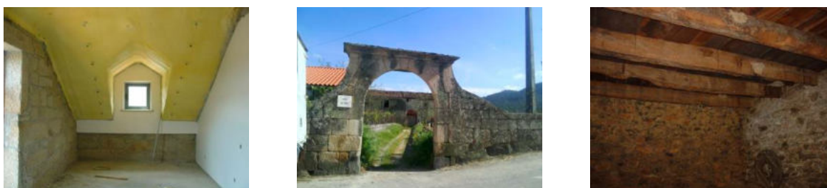
Figura 1. Algumas especificidades próprias dos edifícios a intervencionar
