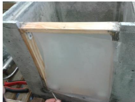
Figura 102 - Descobragem para a parede de trombe
