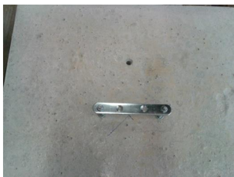
Figura 124 - Fixação do puxador
