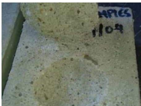
Figura 44 – Rotura pelo suporte
