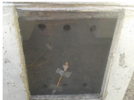
Figura 137 - Colocação de fita-cola
