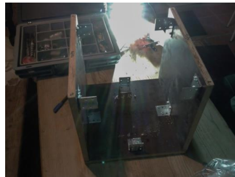
Figura 68 - Execução da cofragem interior
