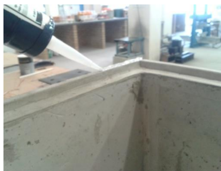
Figura 125 - Colocação de silicone
