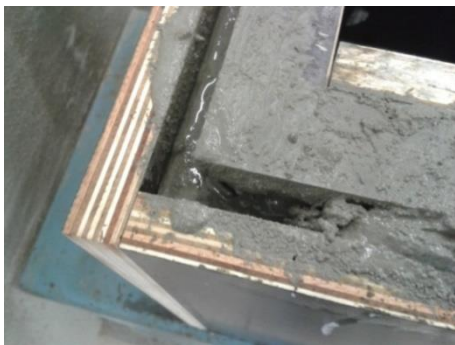
Figura 95 - Betonagem dos lados
