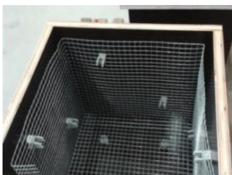
Figura 89 - Colocação da malha e espaçadores
