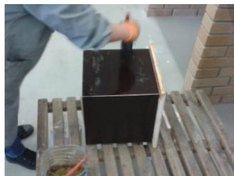
Figura 88 - Aplicação de descofrante no exterior
