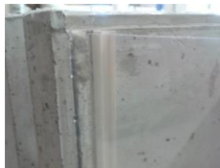
Figura 121 - Fixação da calha de 2 [cm]
