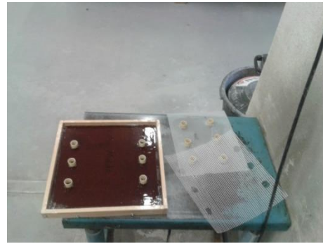
Figura 111 - Aplicação de óleo descofrante
