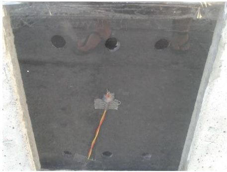
Figura 144 - Orifícios de ventilação
