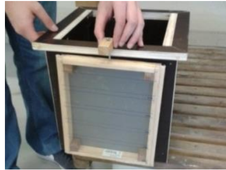
Figura 74 - Junção das cofragens
