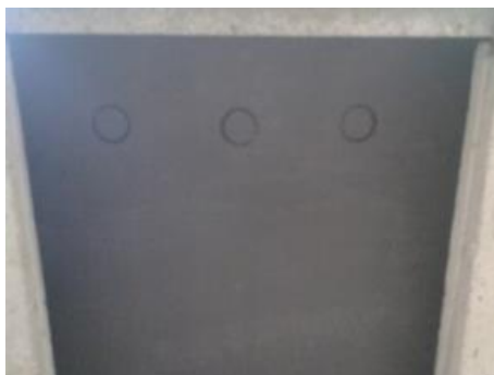
Figura 122 - Colocação dos painéis
