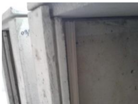
Figura 120 – Fixação da calha de 1,5 [cm]
