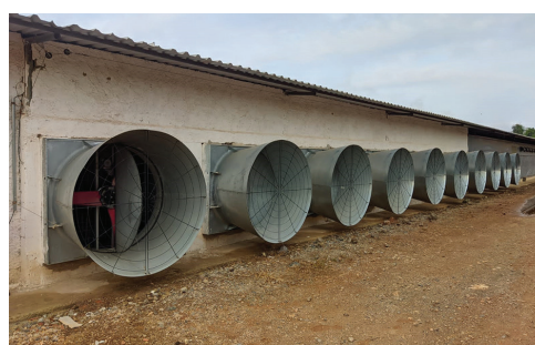
FIGURA 3.14 – (a) Condicionamento térmico natural com cortinas laterais; (b) sistema climatizado com (c) exaustores instalados numa das extremidades de um pavilhão parafrangos de carne com sistemas de ventilação negativa longitudinal.
