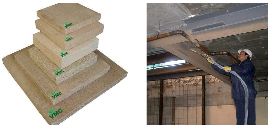
Figura 3.18 – Placa de vermiculite e aplicação em spray como protecção de uma estrutura.
