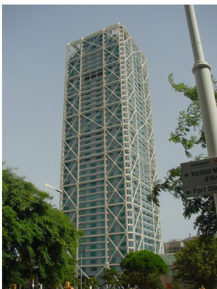
Figura 3.4. – Estrutura resistente colocada no exterior do edifício, em Barcelona.
