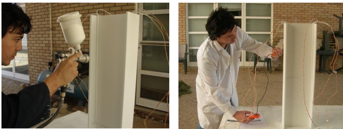
Figura 3.16 – Aplicação do intumescente e controlo de espessura.
