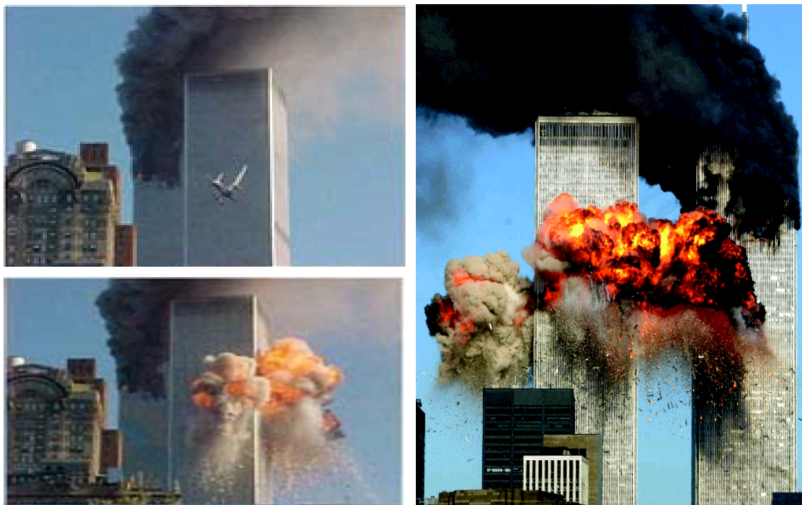
Figura 3.6 – Incêndio com hidrocarbonetos, após a colisão dos aviões nas torres WTC, Nova Iorque, 2001.
