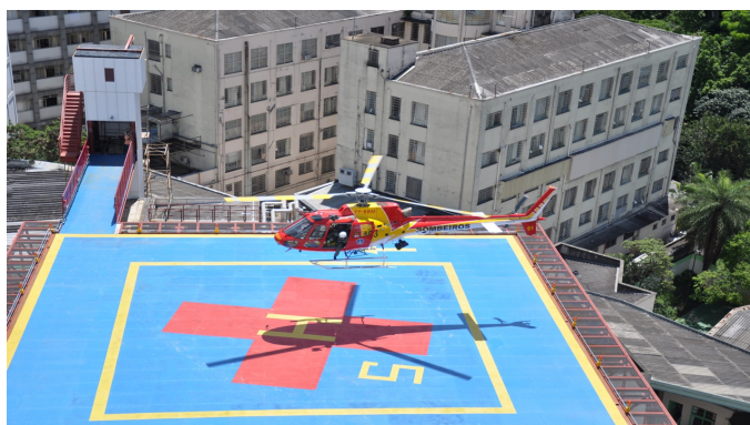
Figura 2.8: Heliporto elevado - Belo Horizonte, Brasil, [11].
