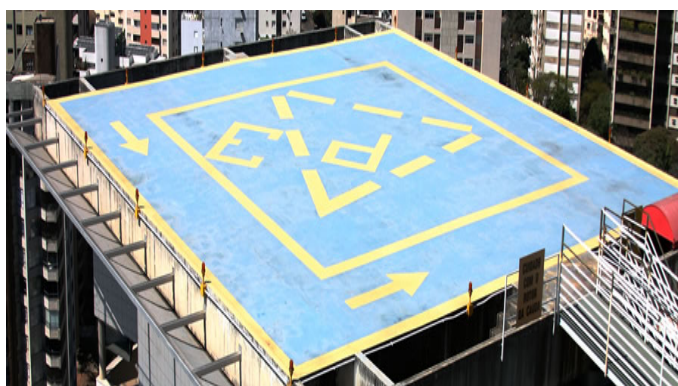
Figura 2.10: Heliporto elevado com estrutura em betão.
