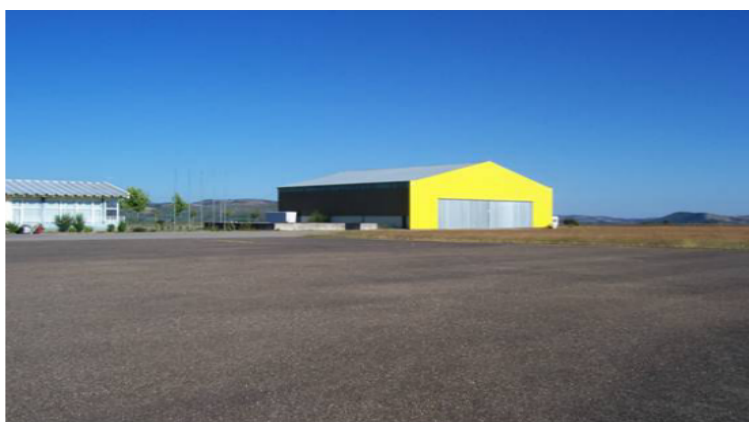
Figura 3.2: Vista exterior do hangar do Aeroporto de Bragança.
