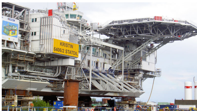
Figura 2.11: Heliporto em alumínio em estrutura offshore , [13].
