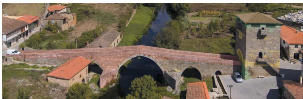
Fig. 4 – Alçado sul da ponte e da torre. A amarelo assinala-se a fase de obras do século XV; a verde regista-se a área intervencionada pela DGEM em 1936-1939 e a vermelho as obras realizadas entre 1988 e 1990.
