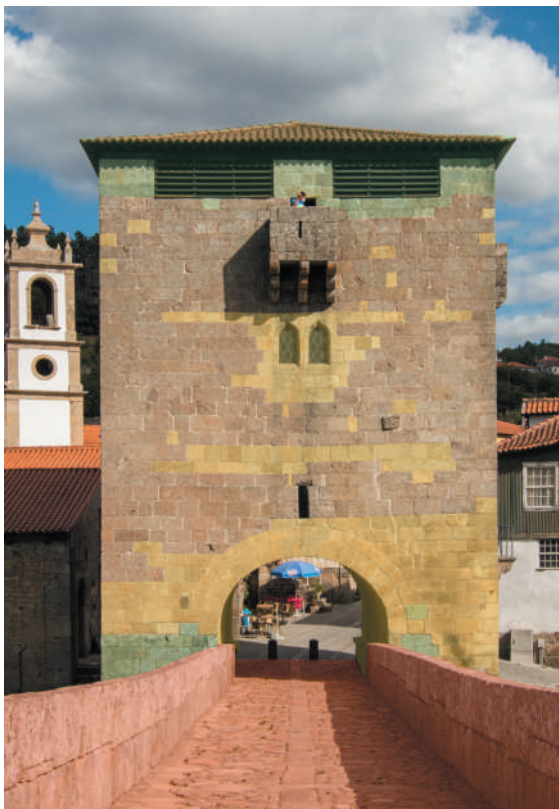
Fig. 7 – Alçado oeste da torre e tabuleiro. A amarelo assinala-se a fase de obras do século XV; a verde regista-se a área intervencionada pela DGEM em 1936-1939 e a vermelho as obras realizadas entre 1988 e 1990.
