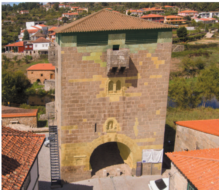
Fig. 6 – Alçado leste da torre. A amarelo assinala-se a fase de obras do século XV; a verde regista-se a área intervencionada pela DGEM entre 1936 e 1939.
