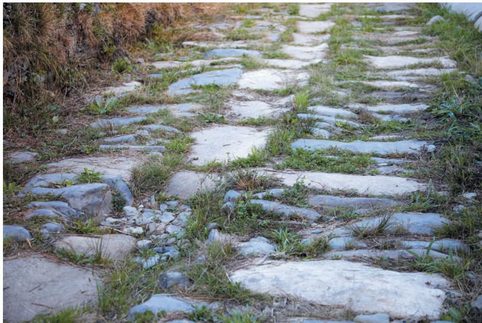
Calçada do Arco da Campeã, Vila Real, 2022
