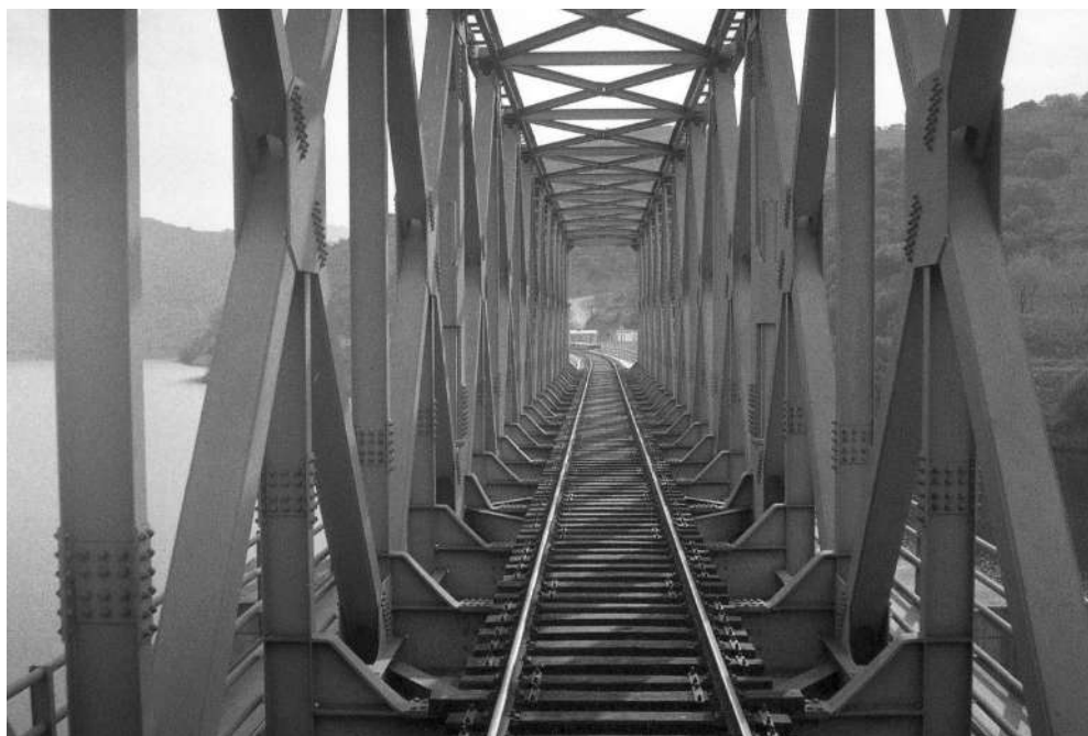
Ponte da Ferradosa, São João da Pesqueira, 1990
