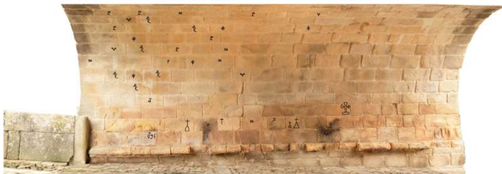
Fig. 3 – Intradorso da abóbada sob a torre com as siglas, os grafitos e a data de 1596 realçadas.
