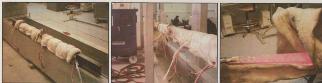
Figura 4.18 – Isolamento térmico das vigas.
