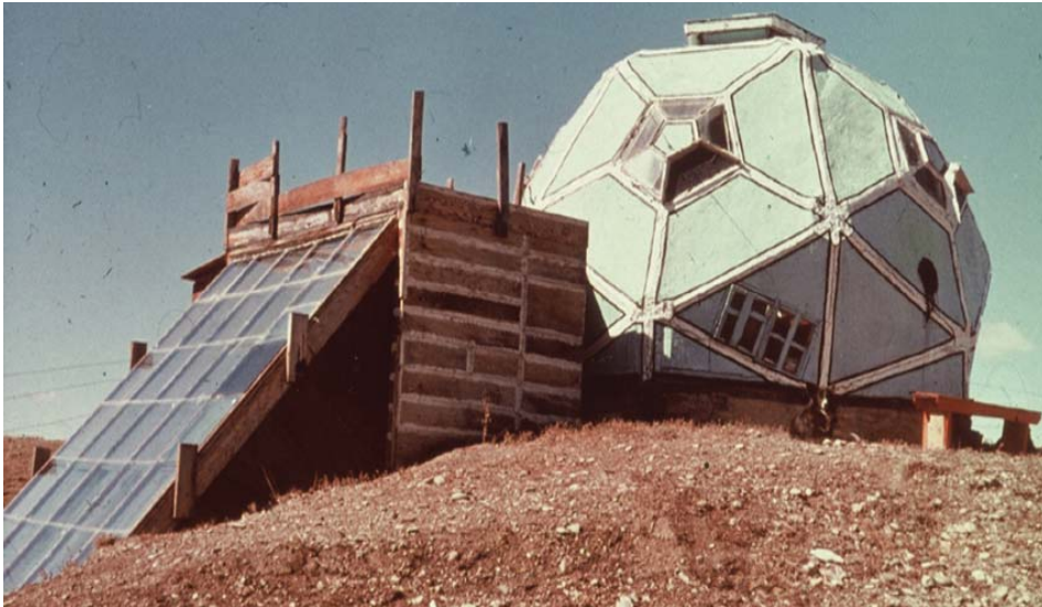
Figura 3. Imagem de casa de Drop City, da década de 70. Estrutura esqueleto, feita com pentágonos e triângulos através do reaproveitamento de chapas cortadas de automóveis para cobrir as faces da dome. Coletores solares para produção de energia e água quente. A contracultura dos novos americanos, põem em prática as suas aspirações ecológicas no desejo de viver em simbiose com a natureza numa procura duma nova poética do espaço.
