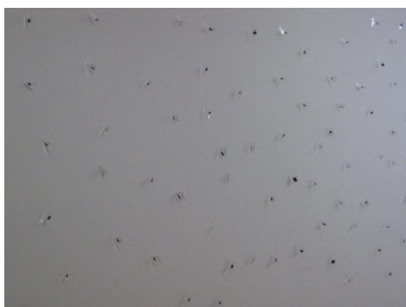
Ilustração 15 - Instalação vista de frente
