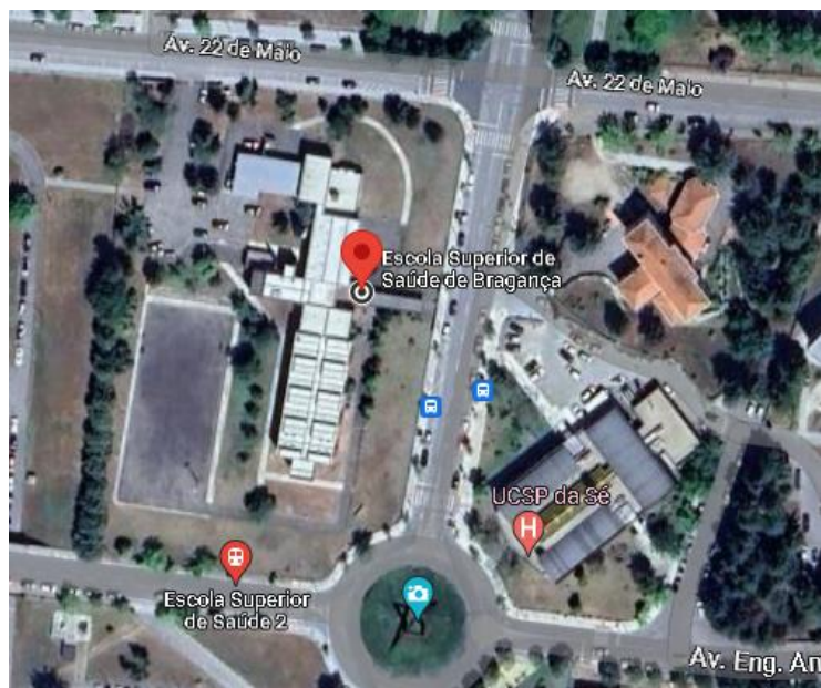
Figura 30: Fotografia aérea da ESSa.
