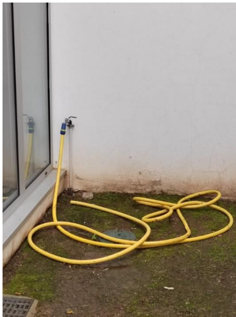
Figura 15: Mangueira localizada no exterior - Domus I.
