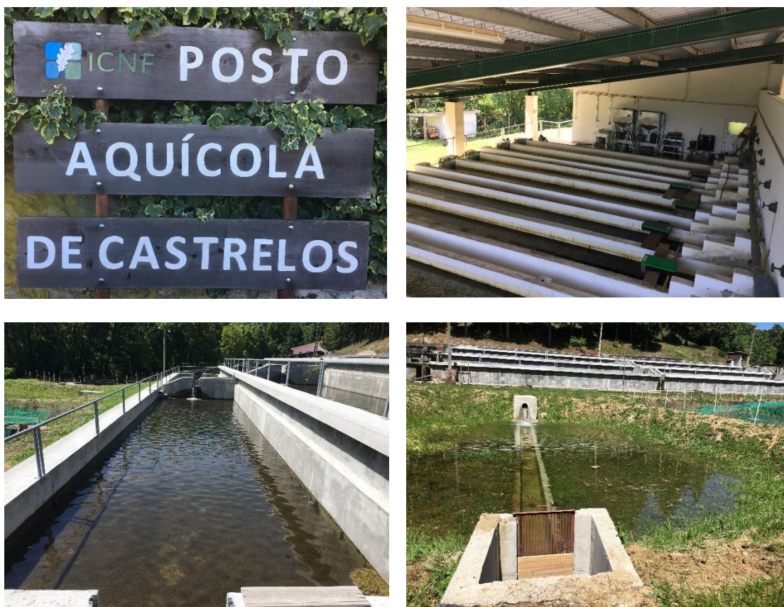
Figura 2.2. Posto Aquícola de Castrelos (Bragança): Tanques da maternidade, Tanques reabilitados e tanques de terra, disponibilizados pelo ICNF para a reprodução ex situ .
