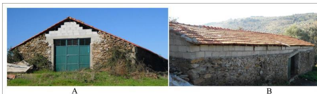
Figura 2. Exemplo de obras de ampliação da porta (A) e de aumento da altura das paredes (B)
