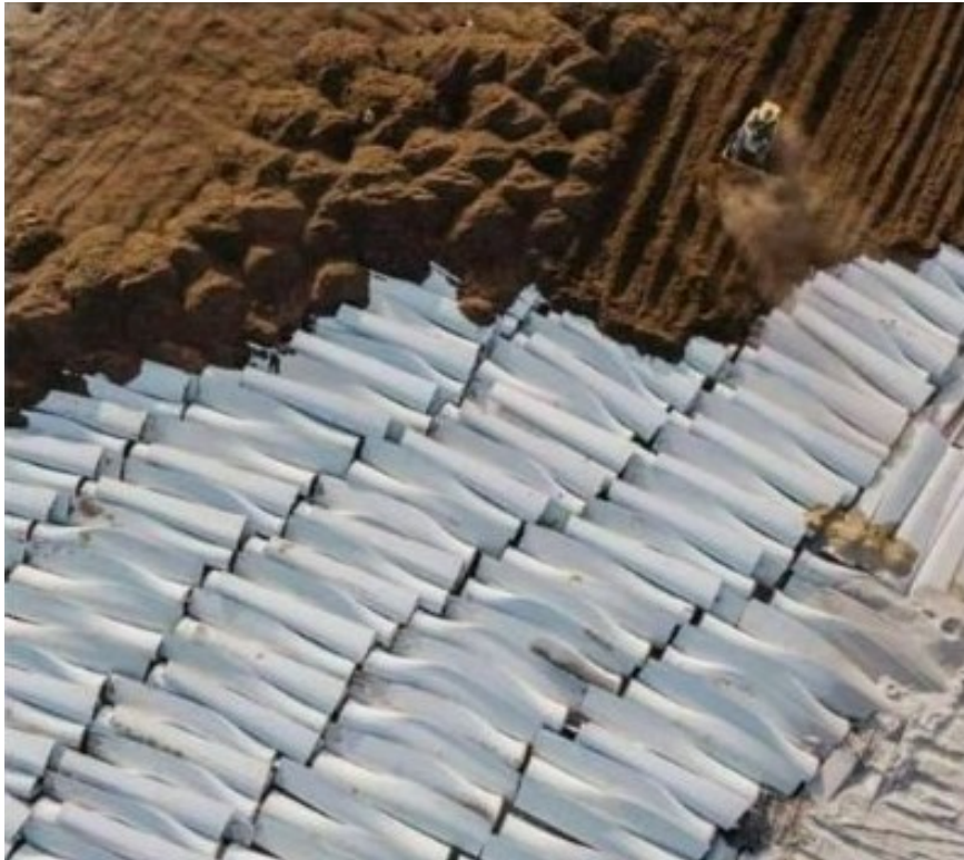
Figura 1.2- Cemitério de turbinas eólicas de Wyoming em Casper, EUA - 9 de Janeiro de 2020. Um total de 870 peças de pás de turbinas eólicas empilhadas em buracos de 30 pés de profundidade no Aterro Sanitário Regional de Casper. (Foto de Benjamin Rasmussen/Getty Images)
