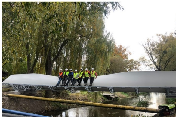
Figura 2.4 – Passarela para pedestres e bicicletas com vigas feitas de pás de turbinas eólicas reaproveitadas 7
