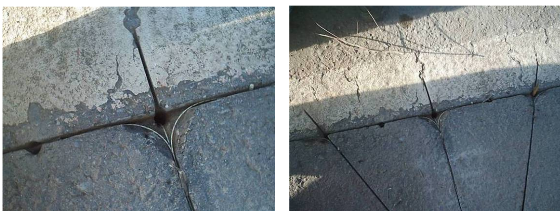
Figura 6.11 – Colocação de termopares no pavimento – aspecto dos termopares colocados nos rasgos antes do enchimento com betume
