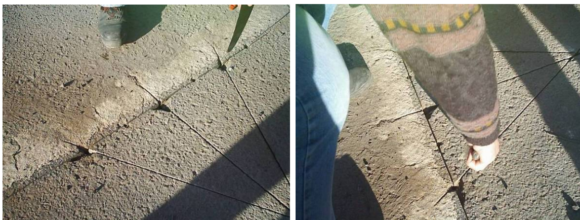
Figura 6.10 – Colocação de termopares no pavimento – abertura de rasgos no pavimento
