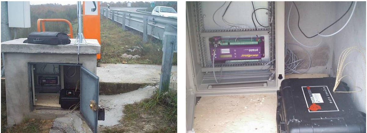
Figura 6.13 – Equipamento de recolha e gravação de dados – dattalogers
