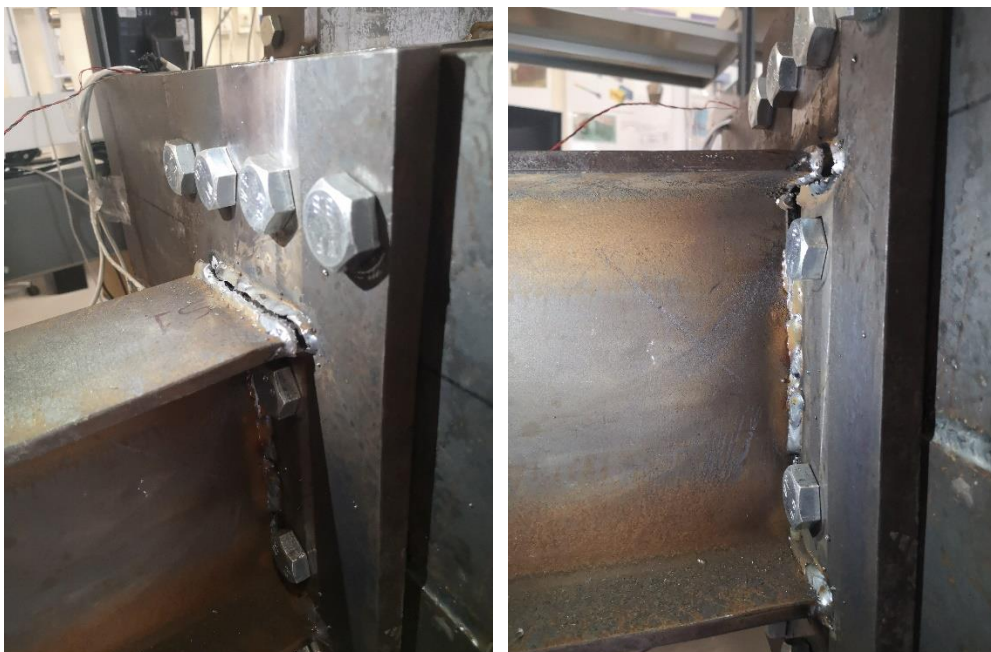
Figura 62 – Ruptura na soldadura entre a viga e a placa de extremidade.
