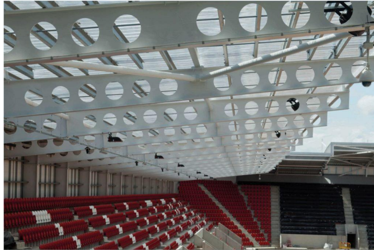
Figura 2 – Estrutura de estádio com vigas alveolares, [4].
