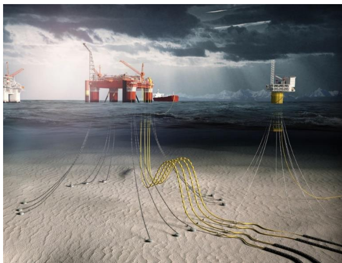
Figura 1 – Plataforma offshore alimentada por dutos flexíveis [2]
