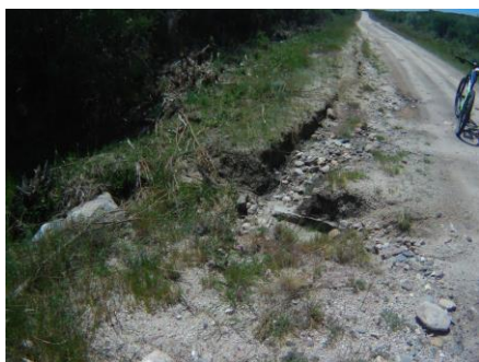
(a) Vala inexistente, conseqüente erosão.
