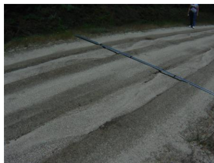
(b) Afundamento trilho de roda.
