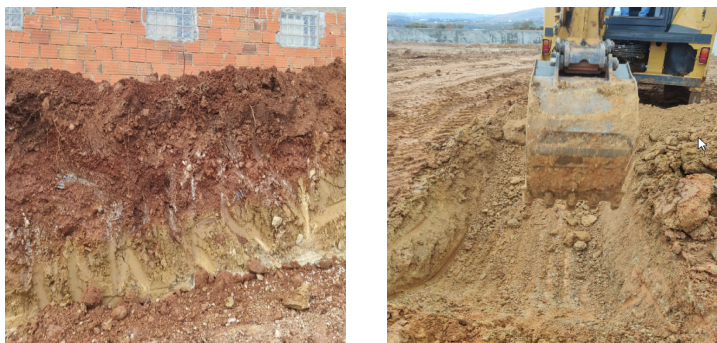
Figura 3.2: a) Corte no terreno em estudo; b) Vala aberta para cravação dos moldes.
