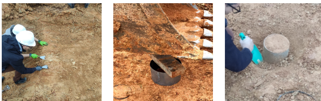
Figura 3.3: a) Regularização manual da superfície; b) Cravação dos amostradores no solo; c) Escavação manual para retirada dos moldes
