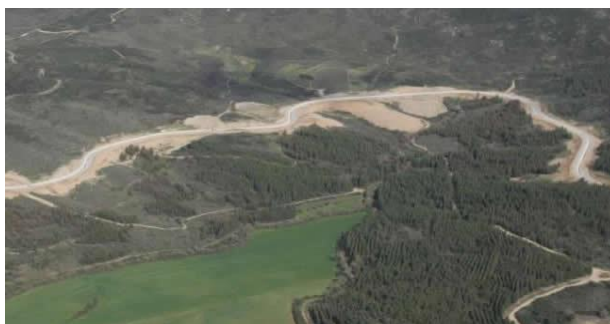
Figura 12 - Periferia da Barragem
