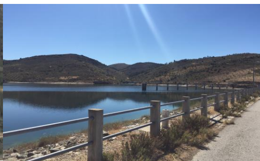
Figura 13 - Barragem de Santa Justa
