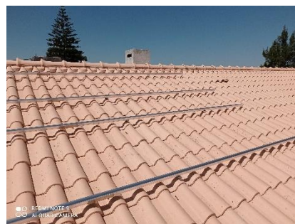
Figura 39: Estrutura de suporte no edifício em estudo
