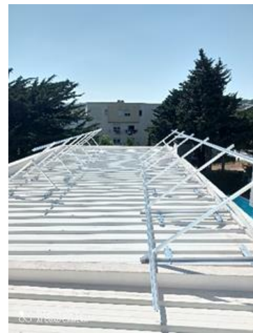
Figura 45: Estrutura no edifício
