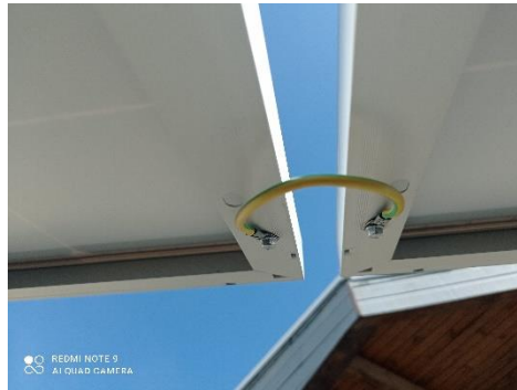
Figura 28:Ligação de cabo Terra
