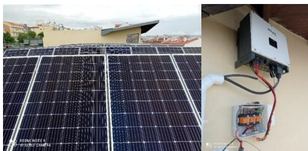
Figura 59: Instalação realizada na escola
