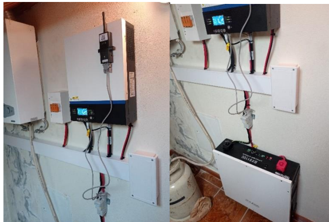
Figura 58: Instalação sistemas híbridos e autónomo
