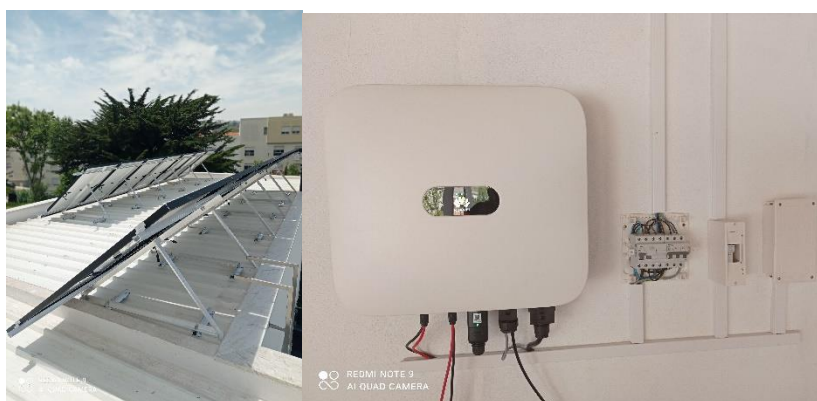
Figura 47: Instalação PV realizada no edificio
