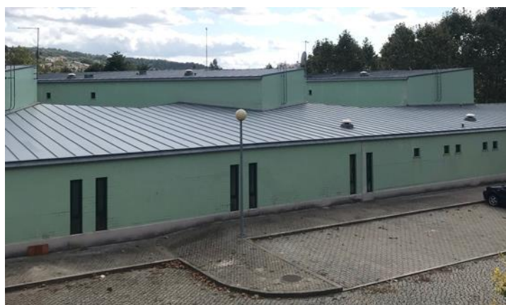
Figura 4.10 - Cobertura da Residência Verde Estudantil.
