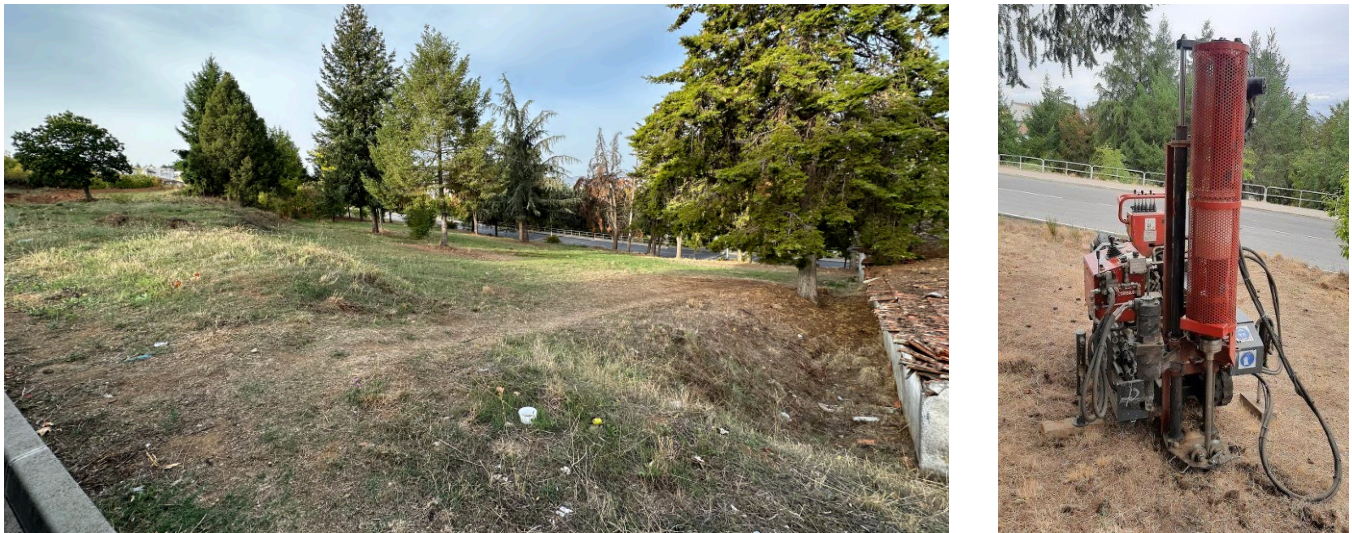
Figura 2 – Local de realização dos ensaios e equipamento de perfuração.
