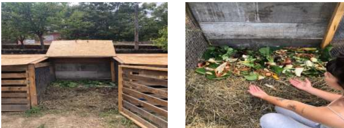
Figura 22: Montagem do módulo 2.
