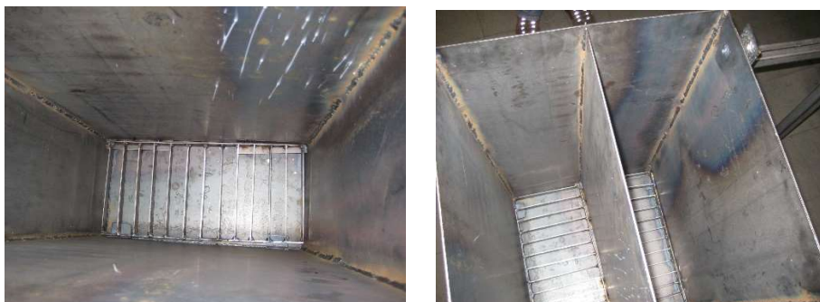
Figura 27 – Colocação da grade do filtro
