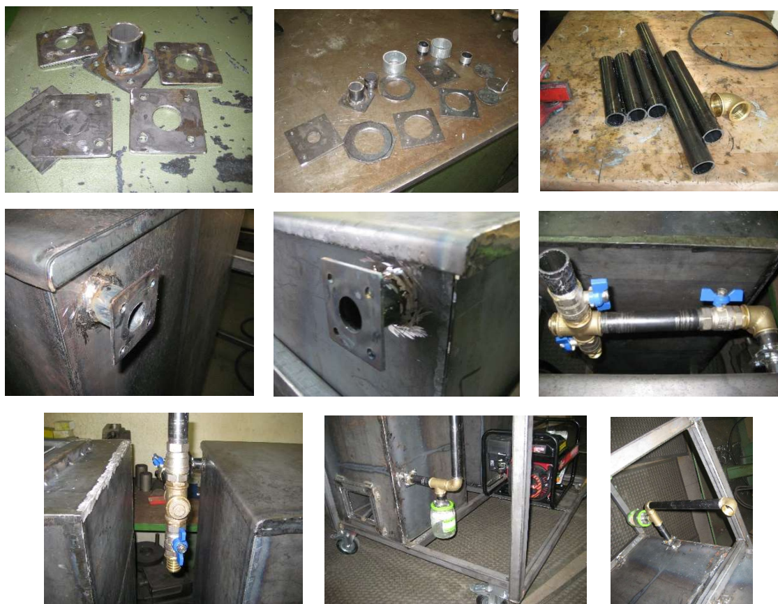
Figura 33 – Colocação das flanges e tubos de ligação
