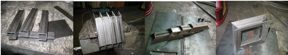
Figura 10 – Construção da entrada de ar na lareira
