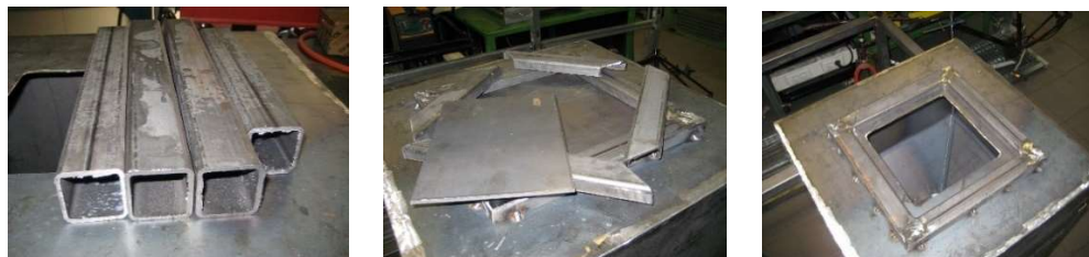
Figura 36 – Construção do rebordo das tampas de gaseificador
