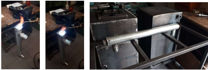
Figura 41 – Soldagem das antecâmaras de gás e ligação ao corpo do permutador
