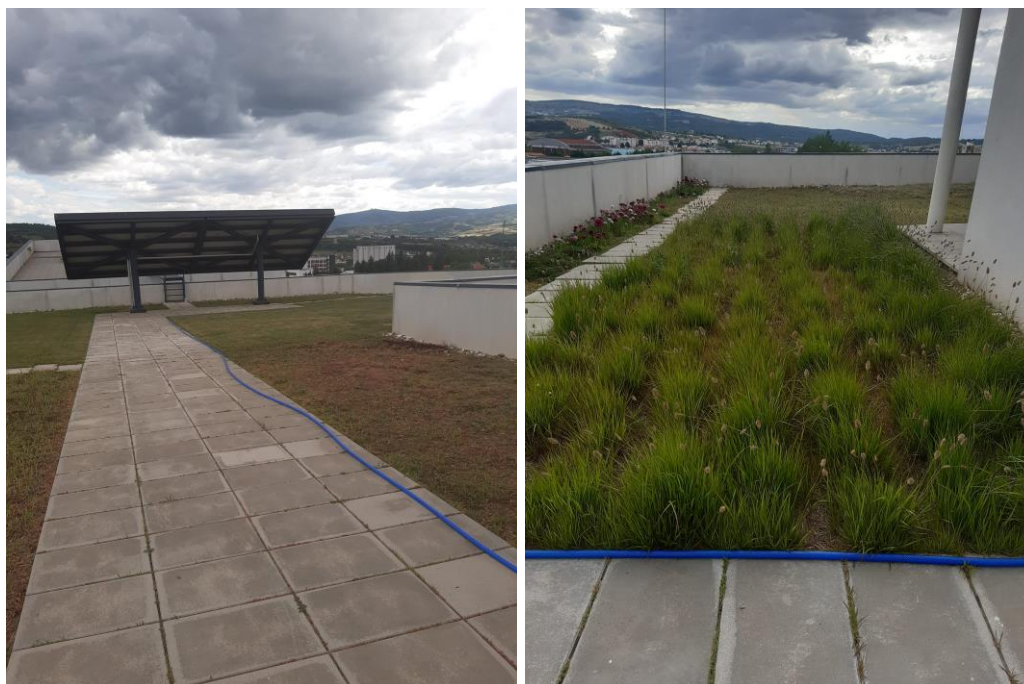
Figura 2.4: Exemplo de cobertura verde no edifício da Câmara Municipal de Bragança.
