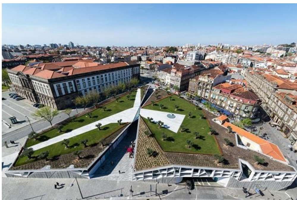
Figura 2.3: Coberturas verdes na Praça de Lisboa, Porto. Disponível em: < https://sustentarqui.com.br/revitalizacao-de-area-no-porto/ >. Acesso em 07 agosto 2024
