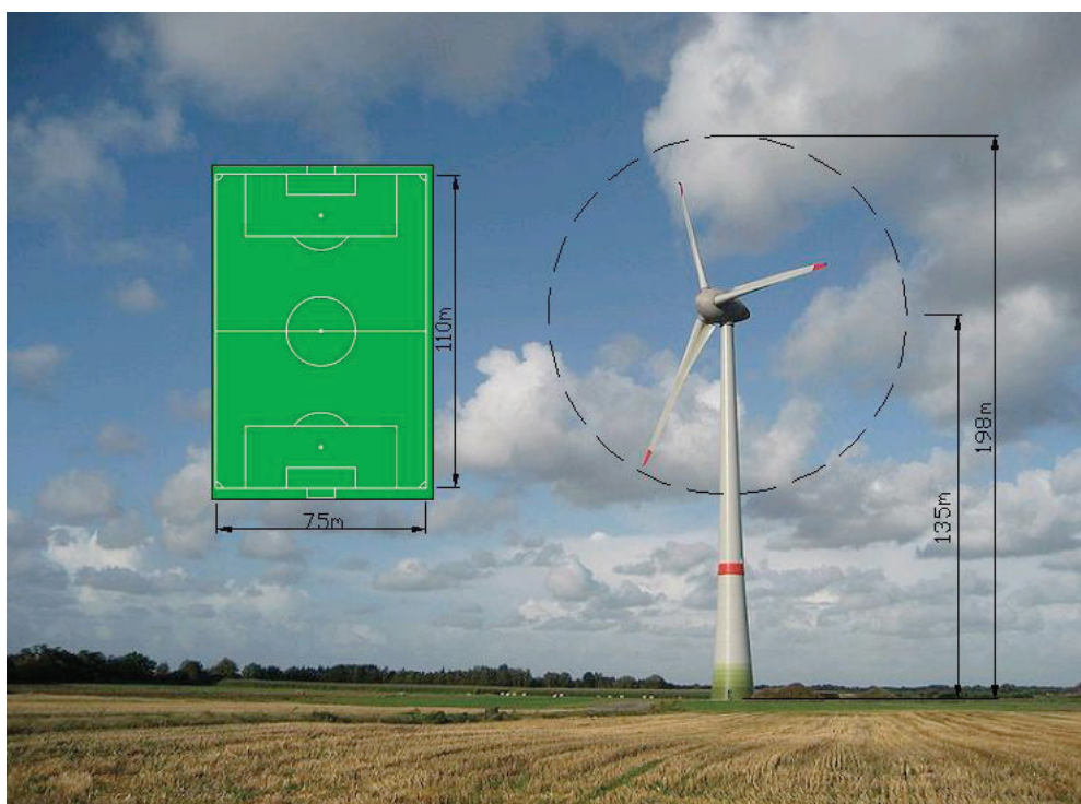
Figura 1. Enercon E-126 – Potência nominal entre 6 a 7,5MW. O eixo do rotor encontra-se a 135 m de altura para um diâmetro de rotor de 126 m. O campo de futebol é apresentado à escala.
