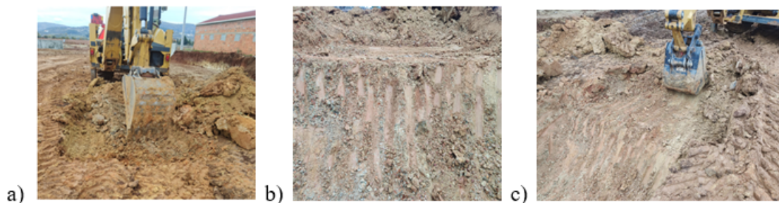
Figura 3.2: a) Perfil do patamar de retirada de amostras; b) Regularização mecânica do patamar de retirada de amostras.
