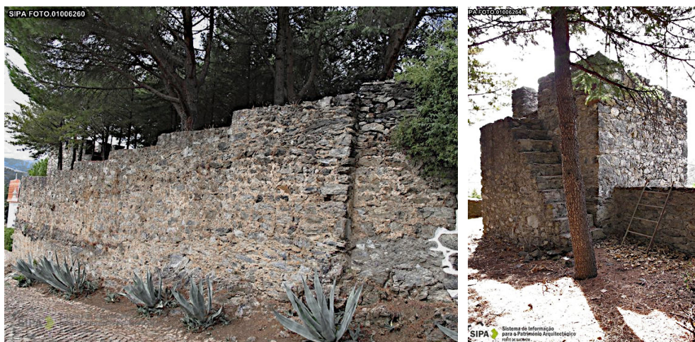
Fig. 2. Pano de muralha (a sul) sendo visível o remate escalonado e vista de ângulo da face interior do cubelo Fonte: Fotografia de Paula Noé, 2010 (SIPA FOTO 01006260 e 01006264) apud NOÉ, 2013a
