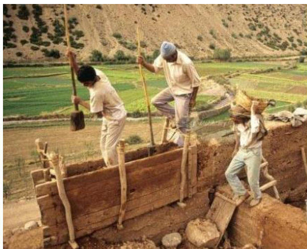
Figura 9. Execução de parede de taipa
