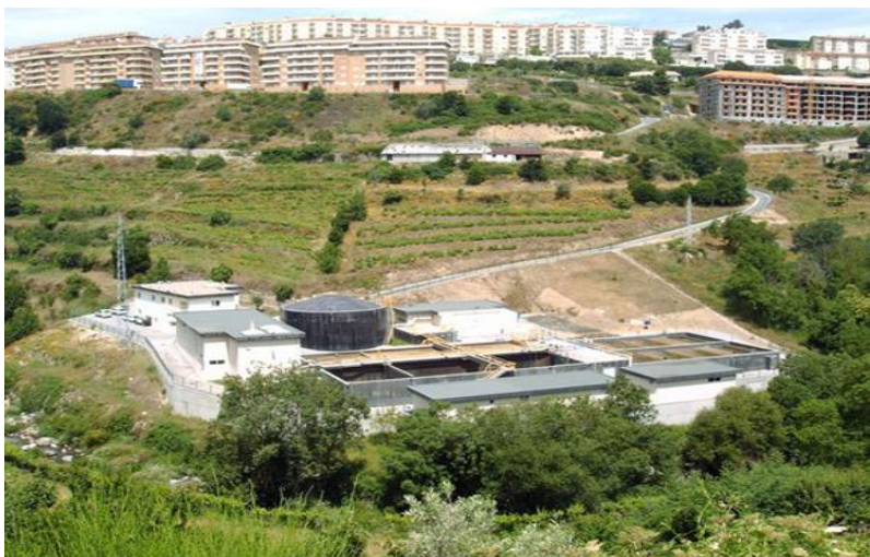
Figura 3- Localização e aspeto geral da ETAR de Lamego.
