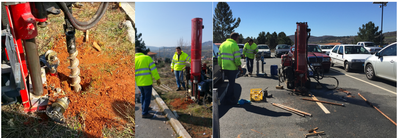
Figura 2 – Standard Penetration Test (SPT) no local da obra. Local interessado pelo estudo e equipamento de perfuração.
