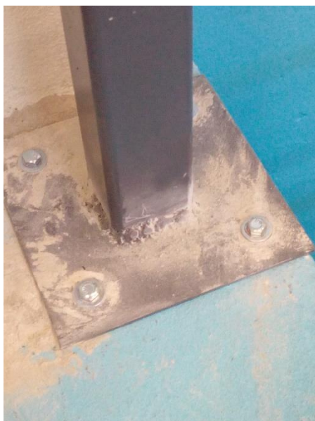
Figura 38. Base das pernas de suporte da estrutura.
