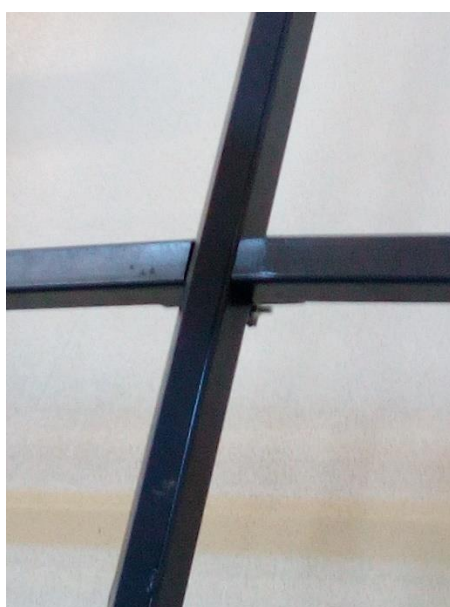
Figura 45. Cantoneira soldada numa das pernas centrais, servido como trilho para rolamentos.
