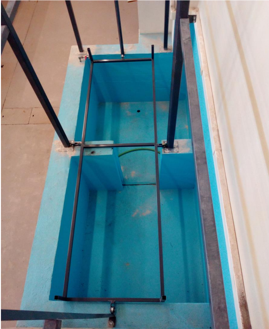
Figura 56. Vista final da parte interior da estrutura (tanque e grelha).
