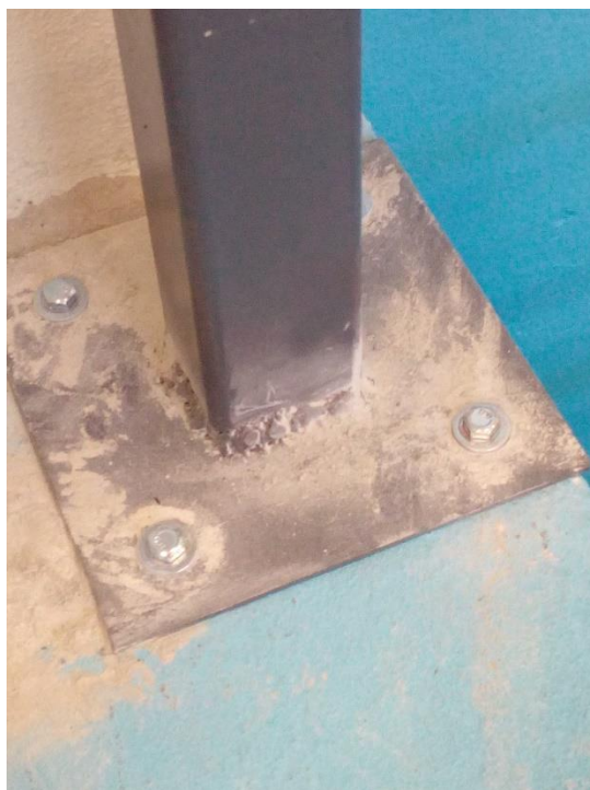
Figura 41. Base de fixação da estrutura soldada na perna.
