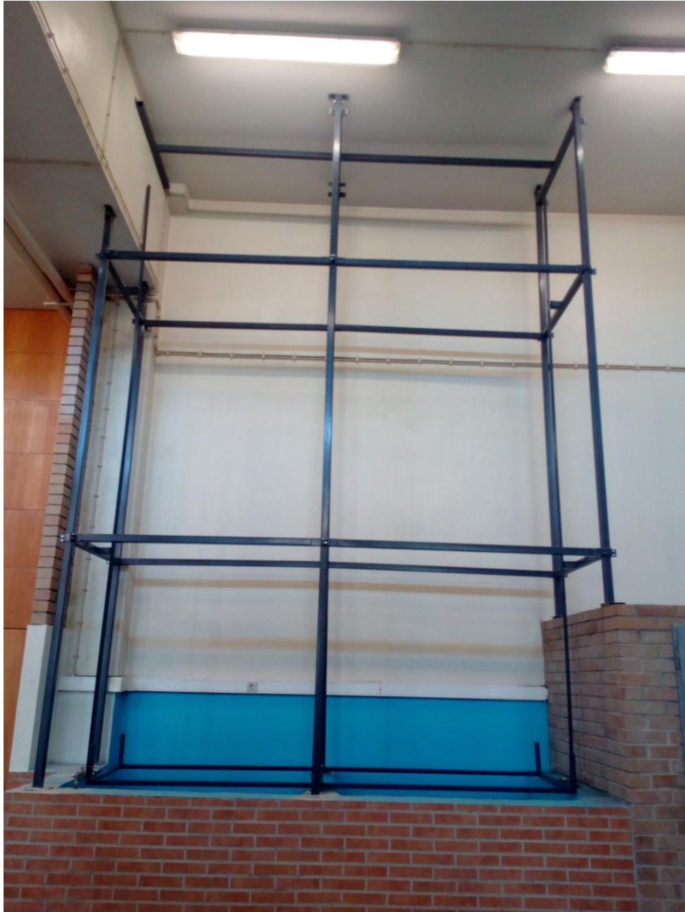
Figura 55. Vista completa da estrutura terminada aplicada no tanque.
