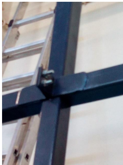
Figura 52. Ligações aparafusadas numa das pernas centrais.
