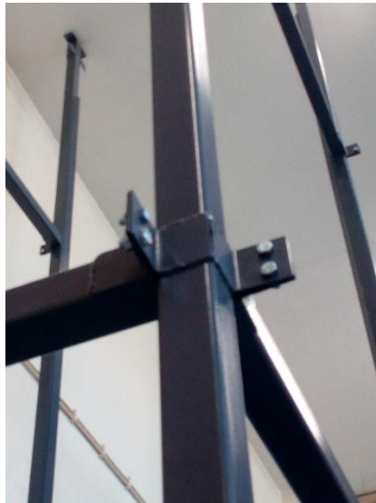
Figura 51. Ligações aparafusadas num dos cantos.
