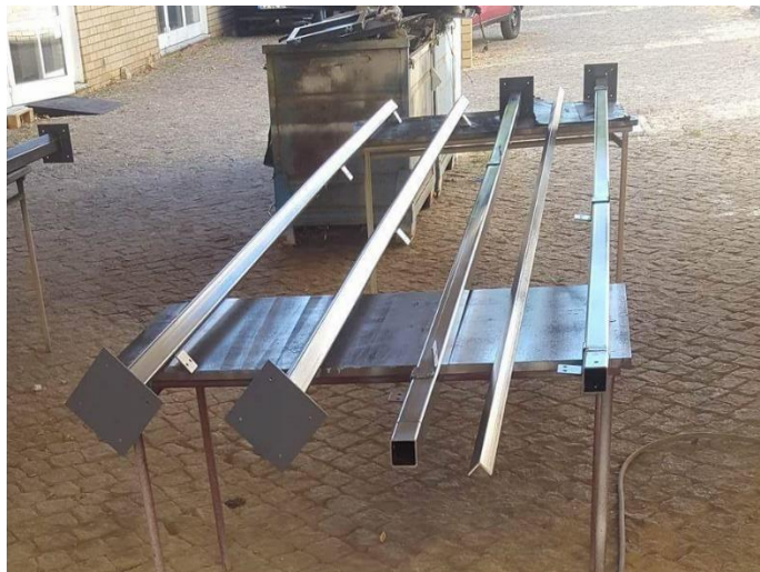
Figura 48. Processo de pintura dos componentes.
